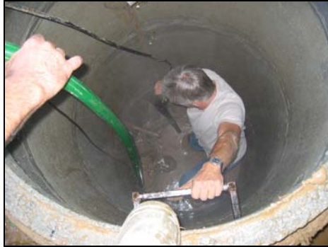
Photo 1. Nettoyage et vidange d'une chambre de visite
