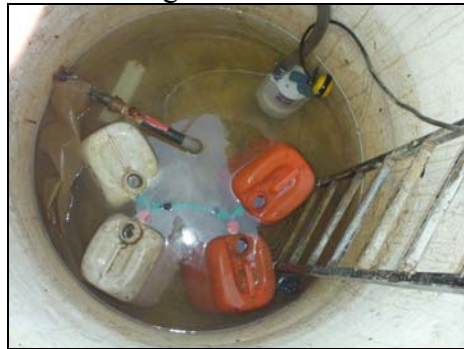
Photo 2. Vidange d'une chambre de visite
